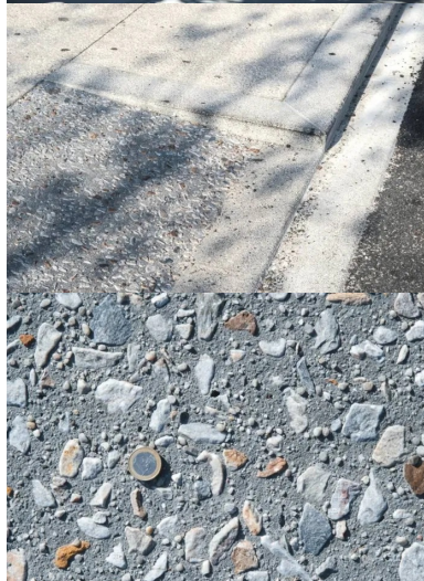
La diversité des finitions donne son caractère à la nouvelle place : microbouchardage ; lissage et (en médaillon) désactivation.
