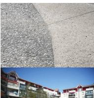
Autre exemple de la diversité des nitions (microbouchardage et désactivation), avec la maîtrise du sciage et de l'intégration des joints au projet esthétique
