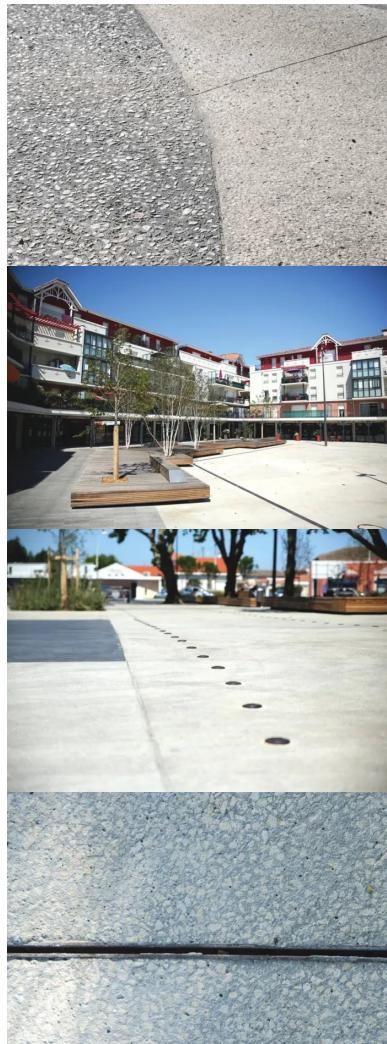
Autre exemple de la diversité des nitions (microbouchardage et désactivation), avec la maîtrise du sciage et de l'intégration des joints au projet esthétique.
