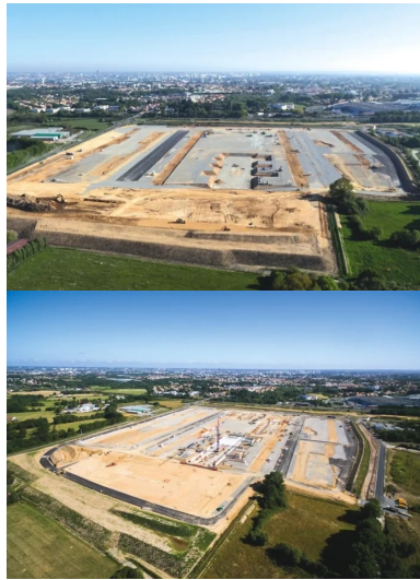
Deux vues aériennes du chantier, l'une en avril 2017 (où le traitement de plate-forme s'achève), l'autre deux mois plus tard, en juin 2017 (où la construction des premiers bâtiments commence).
