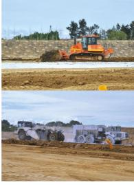
Pour atteindre des portances importantes (notamment 120 MPa pour l'ensemble des 80 000 m2 de voiries), la plateforme a fait l'objet d'un traitement en plusieurs phases : préparation du sol au scarificateur ou au ripper, épandage du liant et malaxage par malaxeur-pulvimixeur
