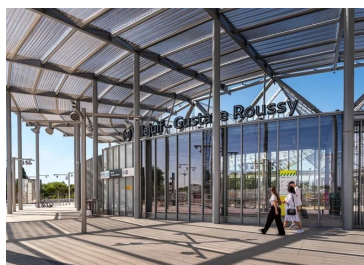
L'important débord de la couverture sert de protection solaire.
