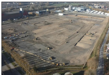
Vue générale du chantier de terrassement. Il a été conçu en circuit fermé déblais-remblais. © Medinger & Fils
