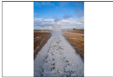
Épandage du liant ROC AS à l'aide d'un épandeur asservi. ©Medinger & Fils
