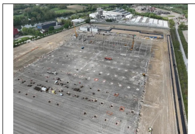
Après la réalisation de la CDF traitée et des fondations (inclusions rigides), la construction du bâtiment a démarré. © Medinger & Fils
