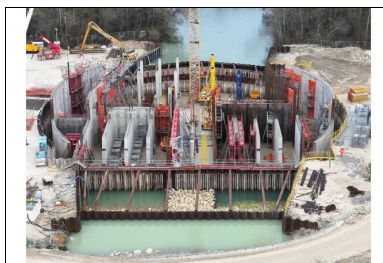
L'enceinte du bâtiment a été délimitée par des rideaux de palplanches avant que soit coulé le bouchon en béton du batardeau principal.
