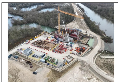
L'emprise a été vidangée afin de réaliser le radier puis les superstructures.
