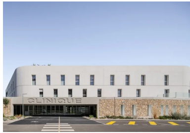
Le soubassement en moellons et les portiques en béton gris renforcent la légèreté visuelle des niveaux supérieurs en béton blanc.
