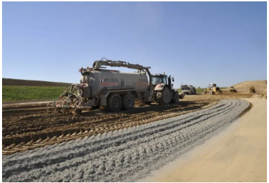
A355, contournement ouest de Strasbourg (67). Vinci Construction Terrassement Grands Projets a réalisé une plateforme support de haute qualité PF4 en améliorant la PST inférieure à la chaux et la PST supérieure au liant ROC COS et en mettant en œuvre une couche de forme traitée au même liant ROC COS d'EQIOM (cf. Routes info #16). © Fenêtre sur cour
