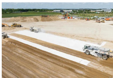
Entrepôt logistique Illies-Salomé, Hauts-de-France (59). Colas a réalisé une plateforme support de haute qualité PF3 en mettant en œuvre une couche de forme traitée au liant ROC VDS d'EQIOM (cf. Routes info #32). © Colas/SACL
