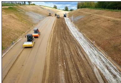
Déviation et mise à 2 x 2 voies de la RN141 entre Roumazières-Loubert et Exideuil-sur-Vienne (16). Guintoli/NGE a réalisé une plateforme support de haute qualité PF4 en renforçant la PST au liant Rolac Premier ECOPlanet et en confectionnant une couche de forme traitée au même liant Rolac Premier ECOPlanet de Lafarge (cf. Routes info #39). ©Guintoli/NGE
