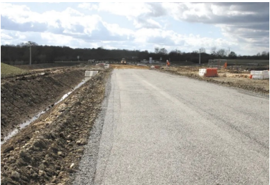
ZAC d'Ozans, Indre (44). Le groupement Sétex (mandataire et pilote) / Eurovia a réalisé une plateforme support de haute qualité PF3 en mettant en œuvre une couche de forme traitée au liant LV-TS 03 de Vicat (cf. Routes n° 125). ©Cimbéton
