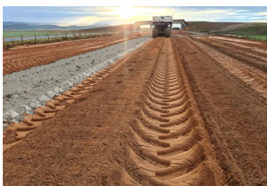
RN102 à Brioude (43). Spie Batignolles Valérian a réalisé une plateforme support de haute qualité PF3 en mettant en œuvre une couche de forme traitée à la chaux puis au liant. ©Maurice Bufalo / Spie Batignolles Valérian
