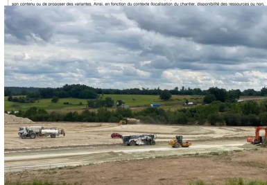
Aire de repos de La Grolle sur la RN10 (16). Ecotab a réalisé une plateforme support de haute qualité PF3 en améliorant la PST à la chaux et en confectionnant une couche de forme traitée au liant Ligex M4 (Bussac) de Heidelberg Materials (cf. Routes info #23/24). © D.Daguzan/Ecotab
