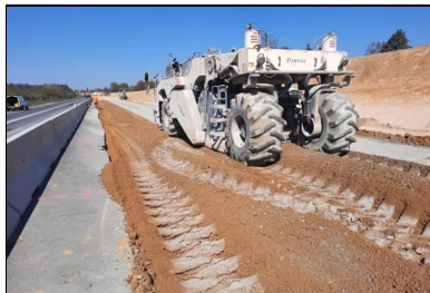
RCEA/79 entre Montmarault (03) et Digoin (71). Eiffage Génie civil a réalisé une plateforme de haute qualité PF4 en améliorant la PST inférieure à la chaux, en renforçant la PST supérieure au liant Ligex M4 et en confectionnant une couche de forme traitée au même liant Ligex M4 de Heidelberg Materials (cf. Routes info #18). ©Eiffage
