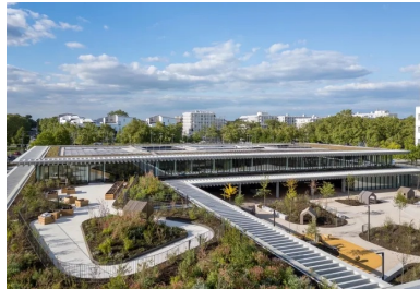
La toiture-terrasse aménagée sur le rez-de-chaussée permet aux élèves d'élémentaire de s'essayer à la culture potagère.
