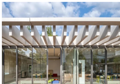
Salle périscolaire du rez-de-chaussée ouverte sur la cour de récréation.
