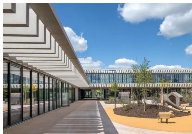
Dans l'enceinte de l'école, comme en périphérie, le bâtiment est entièrement cerné par des ombrières de béton brut lasuré.
