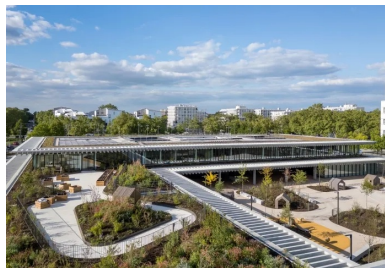
La toiture-terrasse aménagée sur le rez-de-chaussée permet aux élèves d'élémentaire de s'essayer à la culture potagère.
