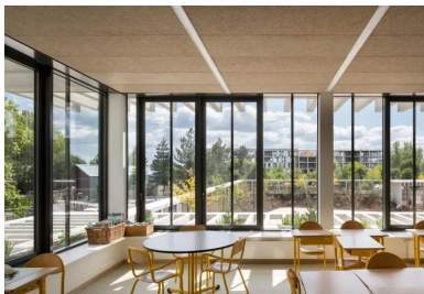
Les faux plafonds en laine de bois sont généralisés sur l'ensemble du bâtiment. Ici, l'angle sud-est d'une salle de classe du R+1.
