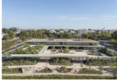
Le groupe scolaire se développe en gradins, entre rez-de-chaussée et R+1, accompagné par les aménagements paysagés. Au premier plan, le parvis avec ses deux entrées, maternelle et élémentaire.
