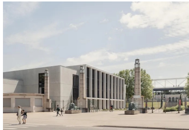
Vue depuis l'avenue Jean-Jaurès sur le centre nautique et sportif, à gauche de l'allée des Lions qui mène au stade.
