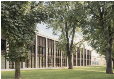
Les murs-rideaux vitrés finement encadrés par les portiques en béton du centre d'entraînement permettent une relation directe avec le parc qui le borde.
