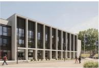
Avec leurs hauts poteaux assemblés de 4 et 10 m, les portiques en béton brut préfabriqués caractérisent la façade nord et rythment l'allé
