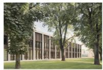
Les murs-rideaux vitrés finement encadrés par les portiques en béton du centre d'entraînement permettent une relation directe avec le parc qui le borde.
