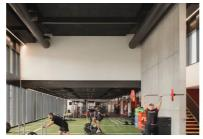
La structure mixte du centre d'entraînement, contreventée par les murs pignons et le refend en béton, dégage de tout porteur l'espace le long de la façade réservé à une piste de course.
