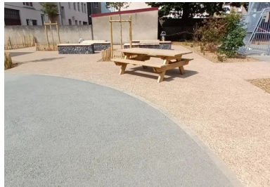
Bétons drainant et désactivé à Thionville. ©EQIOM
