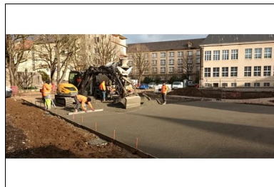
Mise en œuvre du béton drainant à Thionville. ©EQIOM
