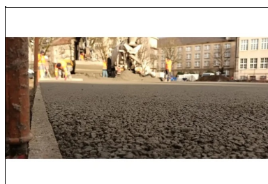
Mise en œuvre du béton drainant à Thionville. ©EQIOM
