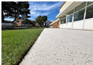
Béton poncé clair au Havre. ©Efcac
