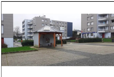
Quartier avant travaux à Laval. ©Plaine Étude
