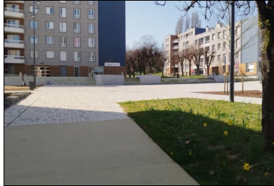
Quartier après travaux à Laval, exemple d'intégration de pavés en béton. ©Plaine Etude
