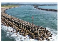
Brise-lames avec tétrapode en béton. © Galih Pradinta/Shutterstock
