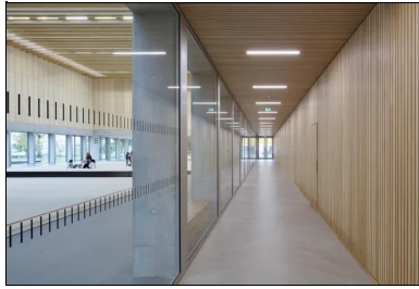
Dans les circulations, permanence du duo béton et bois. Au sol, du béton ciré. Au mur, les tasseaux de bois masquent l'ancien mur béton abîmé tout en assurant le confort acoustique.
