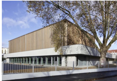
La proximité des arbres remarquables qu'il fallait préserver a nettement compliqué le montage du bandeau béton.
