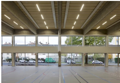
Les portiques béton du gymnase existant mis à jour après leur nettoyage.
