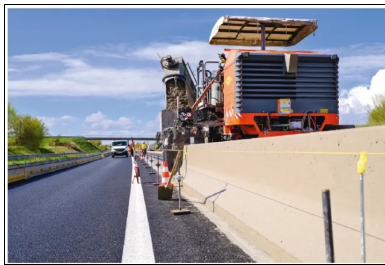
Ph 11. Réalisation de 20 km de séparateur béton sur l'autoroute A28, barrière de Saint-Christophe-sur-le-Mais (37). Ciment utilisé : CEM III/B. © AXIMUM
