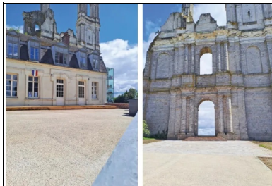
Ph 12. Aménagement du parvis des vestiges de l'abbaye de Mont-Saint-Eloi (62) en béton désactivé. Ciment utilisé : CEM IJC. © SÉBASTIEN CARONEQIOM
