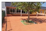
Ph 7. Aménagement et désimperméabilisation d'une école maternelle en béton drainant color à Saint-Martin d'Auxigny (18). Liant utilisé : {CEM II/A + laitier}, équivaler en composition à un CEM II/B-S. © GUILLAUME MERLE
