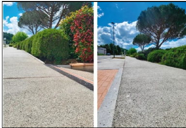
Ph 13. Désimperméabilisation et aménagement d'espaces publics piétonniers, chemin de la Gardie au Séquestre (81). Ciment utilisé : CEM III/B. © LAFARGE
