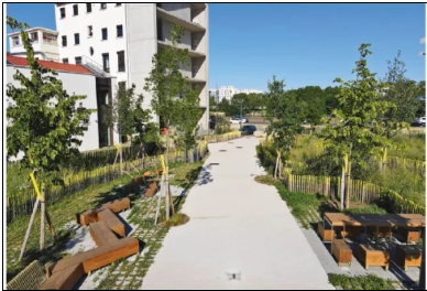
Ph 8. Aménagement piétonnier en béton sablé avec granulat recyclés - Champ Nord Confluence, à Lyon 2. Ciment utilisé : CEM IV/A. © BASE
