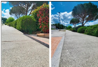
Ph 13. Désimperméabilisation et aménagement d'espaces publics piédonniers, chemin de la Gardie au Séquestre (81). Ciment utilisé : CEM III/B. © LAFARGE
