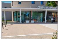
Ph 9. Aménagement de l'entrée d'un hôpital en béton désactivé à Grasse (06). Ciment utilisé : CEM V/A. © GUILLAUME MERLE
