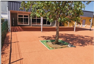
Ph 7. Aménagement et désimperméabilisation d'une école maternelle en béton drainant coloré à Saint-Martin-d'Auxigny (18). Liant utilisé : (CEM III/A + laitier), équivalent en composition à un CEM II/B-S. © GUILLAUME MERLE
