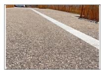
Ph 6. Aménagements piétonniers (BC3) et bus à haut niveau de service (BC5) en béton désactivé à Marseille. Liant utilisé : {CEM I + laitier}, équivalent en composition à un CEM IIJS-5. © CARRIÈRE ET BÉTONS BRONZO PERASSO
