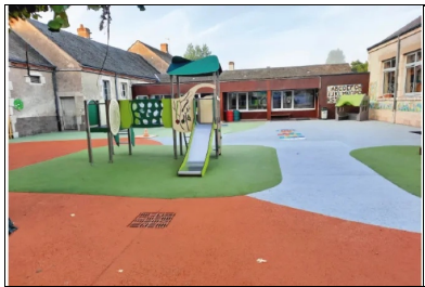
Cour d'école en béton drainant et béton coloré - Désimperméabilisation et délimitation des différentes aires d'activités. © SOCREAM
