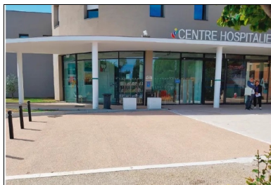
Ph 9. Aménagement de l'entrée d'un hôpital en béton désactivé à Grasse (06). Ciment utilisé : CEM V/A. © GUILLAUME MERLE
