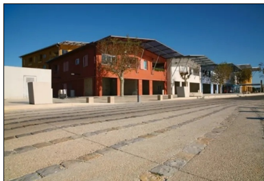
Plateau surélevé en béton texturé - Identification proximité école. © RCR DÉCO FRANCE
