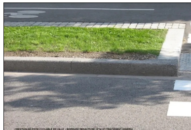
Bordure décorative en béton désactivé - Protection piste cyclable à proximité d'une voirie. © PROFIL
