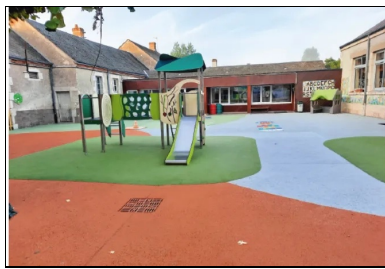
Cour d'école en béton drainant et béton coloré - Désimperméabilisation et délimitation des différentes aires d'activités. © SOCREAM
