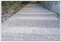
Ph 10. Aménagement d'une véloroute en béton texturé avec cloutage de ballast : EuroVélo 5 dans le Pas-de-Calais (62). Ciment utilisé : CEM II/C. © SÉBASTIEN CARONIECION
