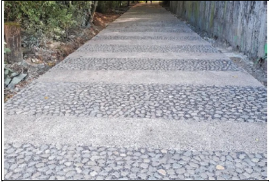
Ph 10. Aménagement d'une véloroute en béton texturé avec cloutage de ballast : EuroVélo 5 dans le Pas-de-Calais (62). Ciment utilisé : CEM II/C. © SEBASTIEN CARONE/EQIOM
