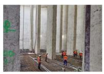
L'intérieur du bassin dévoile un volume monumental, émaillé par 22 barrettes. Ancrées à 81 m de profondeur, celles-ci garantissent la stabilité structurelle de l'ouvrage en toutes circonstances, notamment visà-vis des risques de soulèvement ou de basculement.
