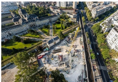
Le chantier est situé à quelques mètres du métro aérien, d'habitations et de l'hôpital de la Pitié-Salpêtrière.
