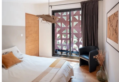
À l'étage, les chambres bénéficient d'une lumière filtrée par la double peau en béton teinté.
