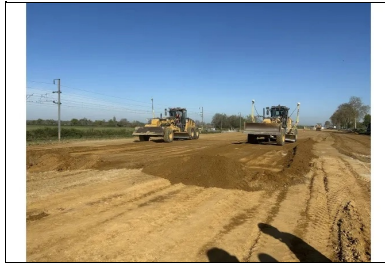
Opération de réglage de la couche de forme. À droite, réglage grossier. À gauche, réglage fin. (©Joseph Abdo/JA-Consulting)
