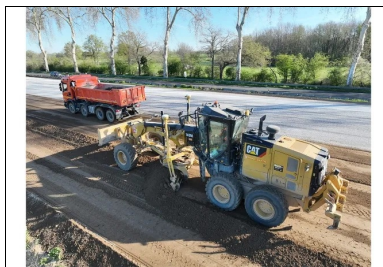
Réalisation de la couche de forme. Acheminement des matériaux B4/B5 par camion et réglage par la niveleuse. (© Roger Martin)
