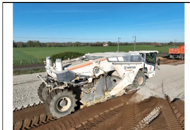
Le malaxeur mélange intimement le liant épandu en surface avec le matériau B4/B5 et sur une profondeur de 38 cm. (©Roger Martin)
