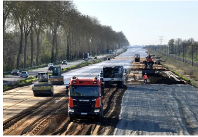
RN7. Vue générale du chantier de mise en œuvre de la couche de forme traitée au liant LV-TS 03. À gauche, l'actuelle RN7, bordée de platanes, et, à droite, la ligne SNCF Paris - Clermont-Ferrand. (© Roger Martin)
