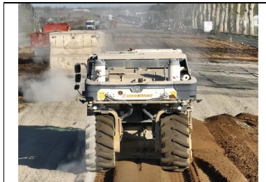
Atelier de traitement constitué d'un épandeur de liant et d'un malaxeur. (©Roger Martin)
