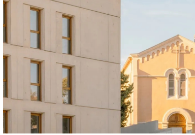
Le bâtiment affiche un béton beige teinté dans la masse qui reprend la couleur des appareillages principaux de l'église voisine.
