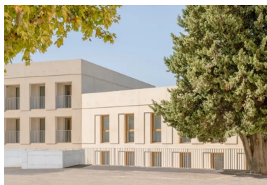
L'épannelage correspond aux différentes typologies de logement : villas en duplex en R+1, logements intermédiaires en R+2 et collectifs en R+3.
