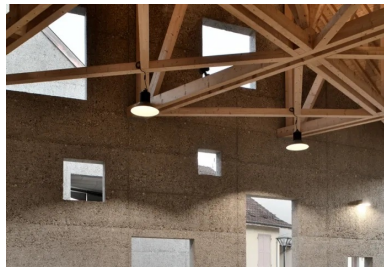
La salle résulte de l'association de deux matériaux bruts : un socle maçonné supportant une charpente en épicea massif.
