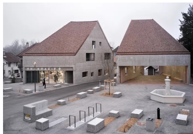
Des blocs multifonctions disséminés sur la place délimitent avec subtilité le nouveau tracé de la voirie.
