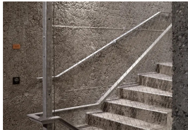
À l'intérieur, quand leur localisation l'autorise, les voiles béton lavés à très haute pression demeurent apparents.
