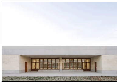
Un auvent en béton brut prolonge la grande salle vers le jardin pédagogique côté est pour abriter les activités des enfants sous son généreux ombrage.
