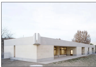
Côté parc, une gargouille surdimensionnée en béton brut met en scène le chemin de l'eau.
