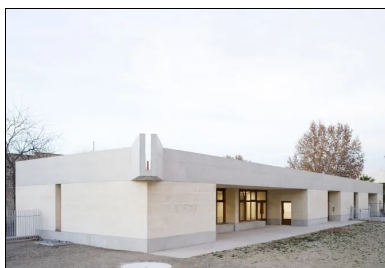
Côté parc, une gargouille surdimensionnée en béton brut met en scène le chemin de l'eau.
