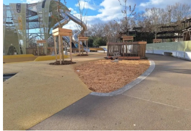
Aire de jeux Caterpillou. Les cheminements en béton recyclé et à empreinte carbone réduite ( finition micro-désactivée) structurent et connectent les espaces de jeux. (© Agence Base)
