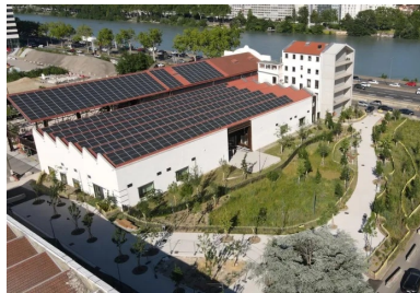
Petit Champ. 9 000 m 2 de cheminements principaux sont réalisés en béton recyclé à empreinte carbone réduite. (© Agence Base)
