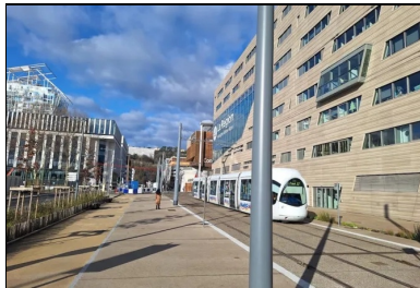
Aménagement en béton micro-désactivé du trottoir et du revêtement de la plate-forme de tramway. (© Detrez, Sols)
