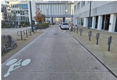
Quartier Marché-Gare. Voirie et trottoirs en béton micro-désactivé. (© Detrez, Sols)
