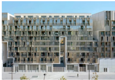
Animée par le jeu toujours changeant des volets mobiles, la façade principale sur l'avenue est rythmée par les porches traversants lumineux et les failles longilignes.
