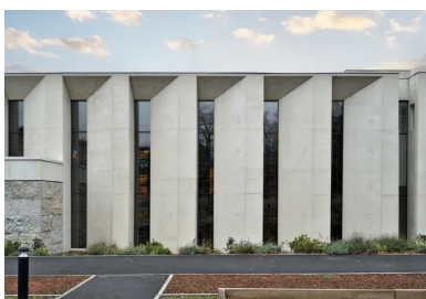
Les pans obliques en béton blanc guident la lumière vers les vitraux colorés et les mettent en valeur à la manière d'écrans.
