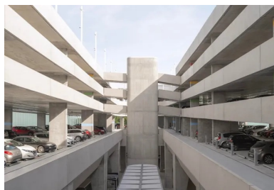
Le plan du bâtiment, structuré autour d'un vide central, favorise l'aération des parkings et diffuse la lumière naturelle jusque dans les moindres recoins.
