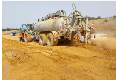
L'arroseuse à enfoncement garantit une teneur en eau optimale.
