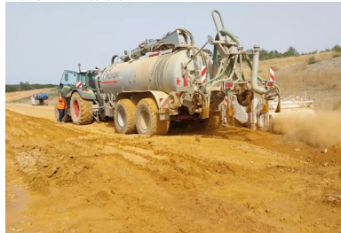
L'arroseuse à enfoncement garantit une teneur en eau optimale.
