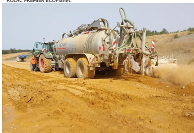
L'arroseuse à enfonnement garantit une teneur en eau optimale.
