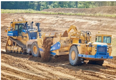
Extraction et transport des matériaux à l'aide de scrapers poussés par des bulldozers et stockage provisoire des déblais. © Guintoli - NGE)
