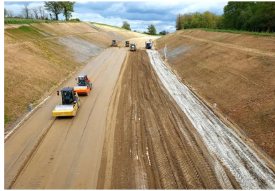
Vue générale du chantier de mise en œuvre de la couche de forme traitée au liant Rolac Premier ECOPlanet. (© Guintoli/groupe NGE)
