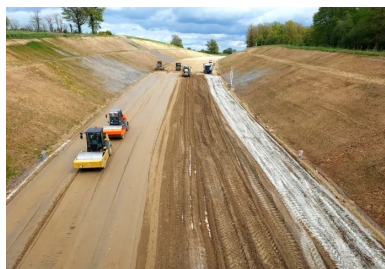
Vue générale du chantier de mise en œuvre de la couche de forme traitée au liant Rolac Premier ECOPlanetet. (© Guintoli/groupe NGE)
