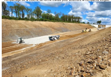
Vue générale du chantier de traitement de la couche de forme. (© Guintoli - NGE)
