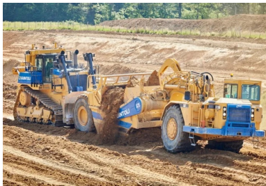
Extraction et transport des matériaux à l'aide de scrapers poussés par des bulldozers et stockage provisoire des déblais. © Guintoli - NGE
