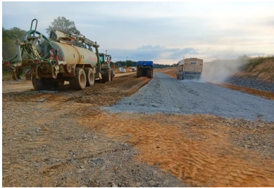
Épandage du LHR Rolac Premier ECOPlanet à la surface du matériau à l'aide d'un épandeur asservi avec contrôle pondéral. © Guintoli - NGE)
