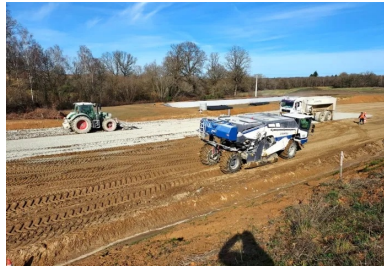
Un malaxeur Wirtgen WR 240i a permis le malaxage du matériau et du liant ROLAC PREMIER ECOPlanet.
