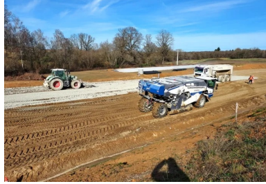
Un malaxeur Wirtgen WR 240i a permis le malaxage du matériau et du liant ROLAC PREMIER ECOPlanet.
