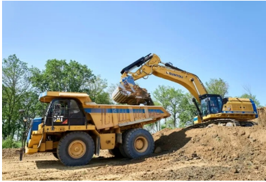
Reprise des déblais sur stock à l'aide d'une pelle sur chenilles et de tombereaux articulés. (© Guintoli - NGE)
