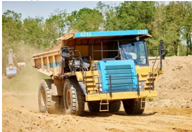
Les matériaux repris sur le stock sont acheminés à l'aide de tombereaux articulés pour être utilisés dans la confection des remblais et de la couche de forme. © Guintoli - NGE
