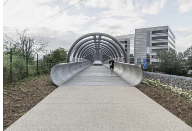
Le débord de l'emprise de la passerelle de part et d'autre du franchissement sécurise les usagers.
