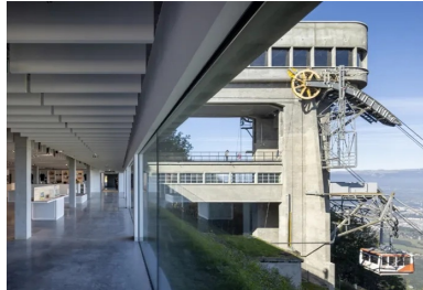
Raccordée au bâtiment-pont, la salle d'exposition s'intègre au paysage.
