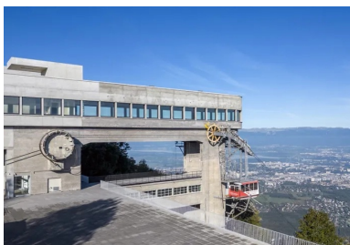
La toiture-terrasse de la salle d'exposition contribue à enrichir les points de vue sur l'environnement.
