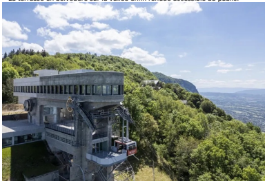
Proue de la gare haute dont l'implantation des piliers correspond au franchissement d'une zone calcaire instable.
