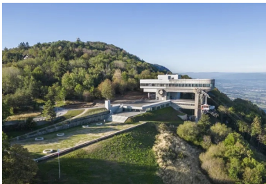
Façade est de la gare haute du téléphérique. Le béton plus clair correspond à l'extension de l'édifice.
