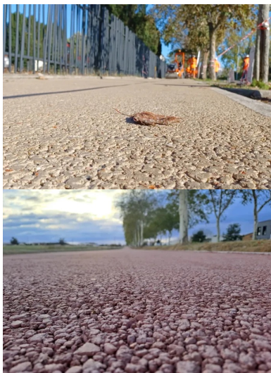
Piste cyclable en BCR poreux avec 90 % de graves recyclées 4/10 et 10 % de sable roulé 0/4, à Lagord (17). (©Spie Batignolles Malet)
