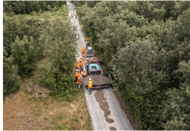
Réfection d'une piste cyclable : mise en œuvre au finisseur d'un BCR bas carbone intégrant 100 % de granulats recyclés. (© Dans le Champ/Spie Batignolles Malet)
