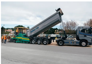
Un camion-benne, bâché durant le transport du BCR, déverse le matériau dans le finisseur. Celui-ci répand, nivelle et compacte le BCR. (© Colas)
