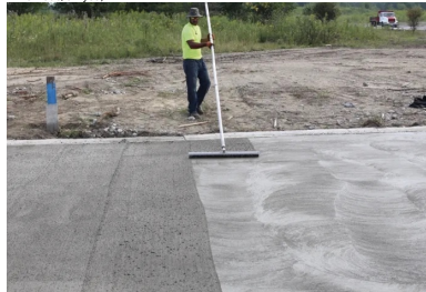
Le BCR reçoit ensuite le traitement de surface prévu : ici, une finition balayée traditionnelle. (©Moderne Méthode/Chryso)
