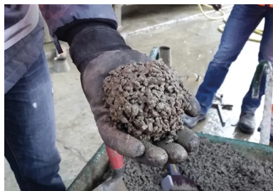
La consistance optimale du BCR, succès de « l'essai à la boule » pour un BCR poreux (©Cimbéton) et pour un BCR de surface. (©Colas)
