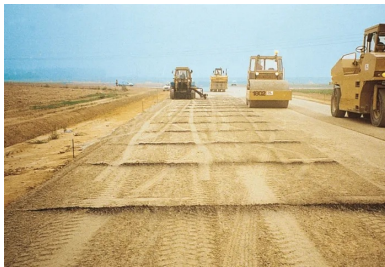
Atelier de compactage du BCR, constitué de rouleaux vibrants suivis d'un compacteur à pneus. (© Cimbéton)
