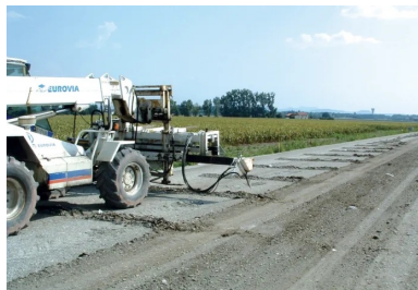
Réalisation de la préfissuration à l'aide de la machine Olivia®. (©Cimbéton)
