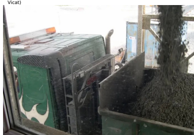
Le BCR peut être fabriqué dans une centrale continue de type grave traitée. (©Cimbéton)
