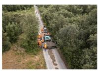
mise en œuvre au finisseur d'un BCR bas carbone intégrant 100 % de granulats recyclés. (©Dans le Champ/Spie Batignolles Male!
