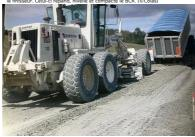
Un camion-benne, bâché durant le transport du BCR, déverse le ma devant la niveleuse. Celle-ci répand et nivelle le BCR. (© Eurovia, X)
