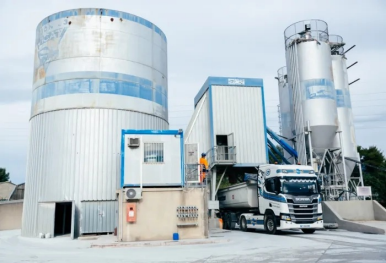
Centrale discontinue de type BPE, où le BCR est étudié et fabriqué. (©Béton Vicat)
