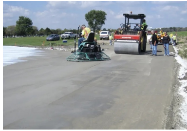
L'adjuvant spécial au BCR s'applique sur la surface juste avant le passage de la truelle mécanique, avec un pulvérisateur à grand débit. Il permet au béton d'être taloché fin, avec suffisamment de pâte cimentaire en surface. (©Moderne Méthode/Chryso)
