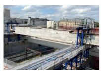
es portiques de levage situés e part et d'autre de la méga-putre permettent de escendre celle-ci jusqu'à sa osition définitive, par ntermédiaire de chevêtres
