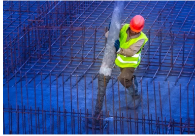
Déchargement BPE sur site
