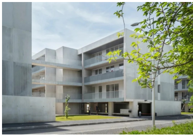
La présence des coursives et des loggias exprime la priorité accordée à la relation étroite entre intérieur et extérieur.
