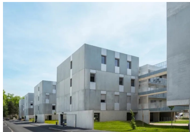
Le jeu entre pleins et vides, entre avancées et retraits, assouplit l'organisation rigoureuse des volumes. Intercalées entre les plots, les coursives offrent un parcours suspendu.
