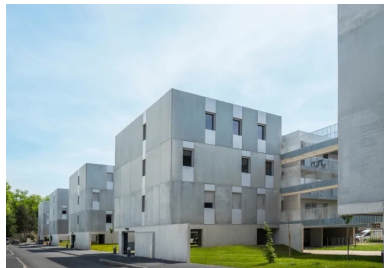
Le jeu entre pleins et vides, entre avancées et retraits, assouplit l'organisation rigoureuse des volumes. Intercalées entre les plots, les coursives offrent un parcours suspendu.
