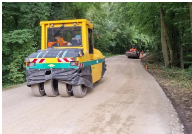
Un atelier de compactage en action. (©Colas)
