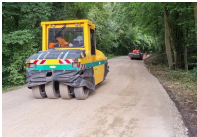
Un atelier de compactage en action. (©Colas)
