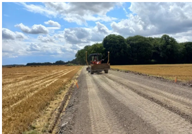
Régalage des fraisats d'enrobés et mise au profil à l'aide d'une niveleuse guidée par GPS. (©Colas)
