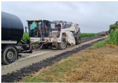
Section 3. Atelier de retraitement mixte au liant ROC VDS (liant épanché au sol) et à l'émulsion de bitume (injectée directement dans la cloche du malaxeur. (©Colas)
