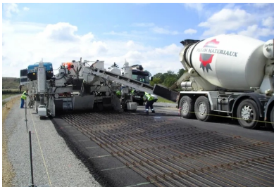
BAC. Positionnement des armatures longitudinales sur des supports ou « distanciers ».
