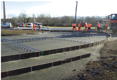
Positionnement des goudjons sur des paniers avant le bétonnage.
