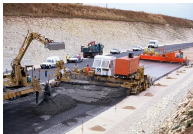
RN 141. Déviation des Rassats-Favrouds- Mise en œuvre de la chaussée composite en BAC/GB3 en 1998. Cette structure assure parfaitement son rôle aujourd'hui sans avoir fait l'objet d'entretien structurel (Cf. interview Gilles Lacassy, DIRA).
