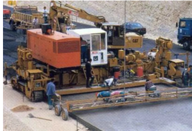
Mise en œuvre du béton à l'aide d'une machine à coffrages glissants.
