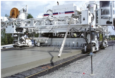
Mise en œuvre d'une structure en BAC/GB3. La propreté de la grave bitume est indispensable pour assurer le collage à l'interface béton/grave bitume
