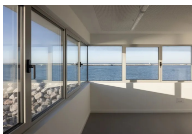
Les menuiseries sont parfaitement étanches afin de ne pas laisser pénétrer le sable et les embruns.
