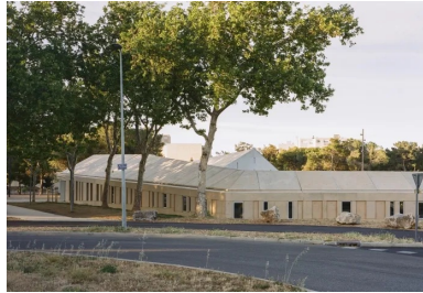
Les architectes ont choisi de réaliser la toiture en continuité des façades en béton sablé et teinté dans la masse pour unifier les différents plans et assurer une grande pérennité au bâti.
