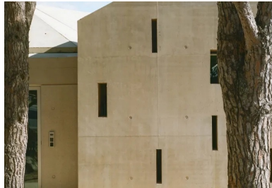
En pignon, un jeu de meurtrières anime la surface de béton.
