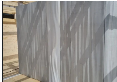
Éléments en BEFUP du Pavillon éphémère JO 2024 de la Fédération de Canoë-Kayak, conçu et réalisé par l'ENA de Grenoble
