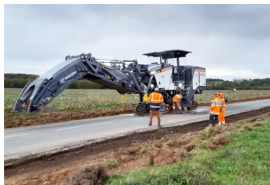
Fragmentation de l'ancienne chaussée sur 15 cm et régalaage du matériau décohesionné sur toute la largeur de la nouvelle plate-forme de chaussée. (©Ludovic Pasdeloup/Conseil départemental de la Vienne)
