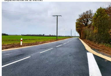
Le tronçon rénové de la RD7 a reçu un nouveau tapis d'enrobés (EB10 sur 6 cm d'épaisseur), avant d'être ouvert à la circulation le 16 décembre 2022. (©Ludovic Pasdeloup/Conseil départemental de la Vienne)
