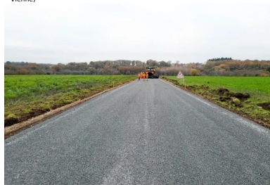
Mise en œuvre de la couche de surface en EB10. (©Ludovic Pasdeloup/Conseil départemental de la Vienne)
