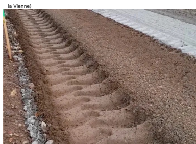
Malaxage du matériau de l'ancienne chaussée avec le liant Ligex M10 sur une profondeur de 35 cm à l'aide d'un pulvimixeur moderne Wirtgen WR240i, permettant d'obtenir un matériau homogène sur toute l'épaisseur et sur toute la largeur de la nouvelle chaussée. (©Ludovic Pasdeloup/Conseil départemental de la Vienne)
