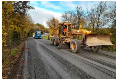
Mise en œuvre de la couche anti-remontée de fissures en grave non traitée sur une épaisseur de 8 cm. (©Ludovic Pasdeloup/Conseil départemental de la Vienne)
