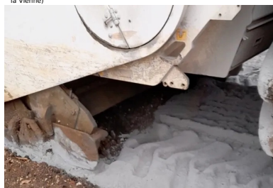
Malaxage du matériau de l'ancienne chaussée avec le liant Ligex M10 sur une profondeur de 35 cm à l'aide d'un pulvimixeur moderne Wirtgen WR240i, permettant d'obtenir un matériau homogène sur toute l'épaisseur et sur toute la largeur de la nouvelle chaussée. (©Ludovic Pasdeloup/Conseil départemental de la Vienne)
