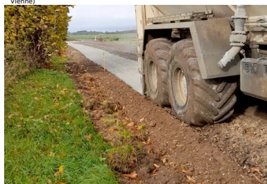
Épandage du liant Ligex M10 à raison de 35 kg/m 2 (dosage 5%) à l'aide d'un épandeur moderne doté d'un système de dosage volumétrique asservi à la vitesse d'avancement. (©Ludovic Pasdeloup/Conseil départemental de la Vienne)
