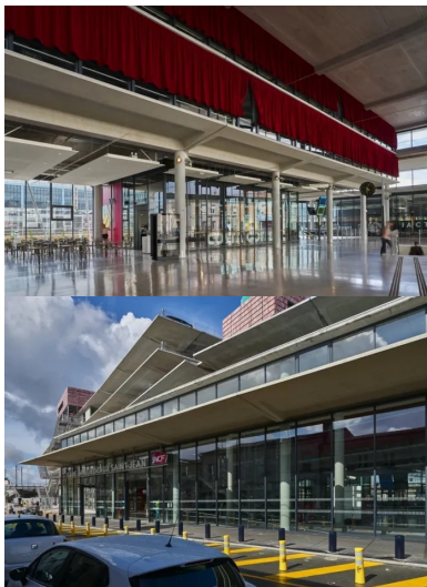
dans la continuité du hall, l'espace d'attente et d'accueil se glisse sous le premier niveau partiel de parking perceptible derrière les rideaux rouges.
