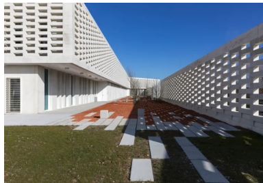
Les éléments préfabriqués des claustras sont réalisés en béton autoplaçant et autonettoyant.
