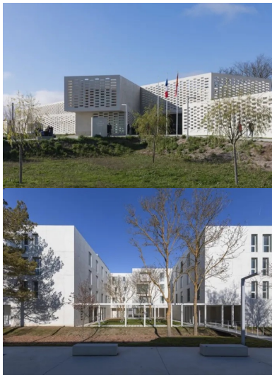
Les éléments préfabriqués des claustras sont réalisés en béton autoplaçant et autonettoyant.
