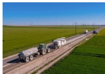
Le retraitement des chaussées en place aux liants hydrauliques routiers est une technique d'entretien structurel qui consiste à valoriser les matériaux de la chaussée existante pour créer une structure **homogène** capable de supporter les sollicitations du trafic. L'ancienne chaussée est ainsi considérée comme un gisement de granulats et non comme un **déchet**.
