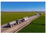
Le retraitement des chaussées en place aux liants hydrauliques routiers est une technique d'entretien structurel qui consiste à valoriser les matériaux de la chaussée existante pour créer une structure homogène capable de supporter les sollicitations du trafic. L'ancienne chaussée est ainsi considérée comme un gisement de granulats et non comme un déchet.
