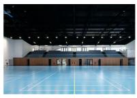
Gymnase - Une nappe structurelle faite de six poutres métalliques en treillis, peintes en noir, permet de franchir les 45 m de portée
