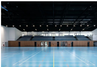
Gymnase – Une nappe structurale faite de six poutres métalliques en treillis, peintes en noir, permet de franchir les 45 m de portée libre.
