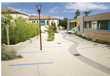
Aménagement urbain en béton coloré et désactivé.
