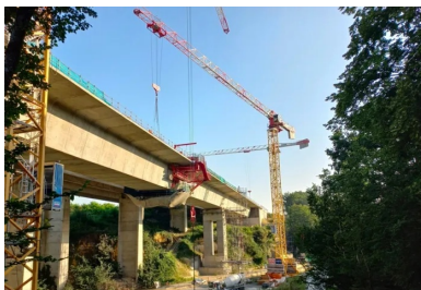
Par souci d'harmonie esthétique avec les ouvrages existants, la hauteur du tablier est constante (5 m).
