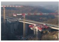
Afin d'éviter tout déséquilibre de la structure, les voussoirs sont construits en encorbellement, symétriquement de part et
