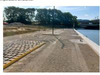
vue un con-coulage du béton, montrai fondation en grave traitée LHR, les coffrages posés, le contraires de rive et le pava
