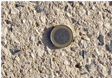
Sablage léger pour la voie piétonne. (©Joseph Abdo/JA-Consulting)
