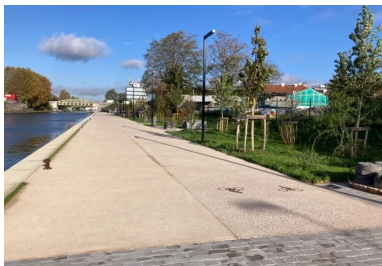
Vue du revêtement en béton avec un sablage léger pour la voie piétonne et un sablage plus prononcé pour la piste cyclable. (©Joseph Abdo/JA-Consulting)
