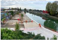
Le béton est réglé manuellement à l'aide d'une règle en aluminium, tout en respectant les repères altimétriques constitués, d'un côté, par les bordures de rive et, de l'autre côté, par des marques portées sur des piquets « repères ». (GSébastien Vinatier/Sols)
