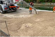
Le béton est acheminé à pied d'œuvre par camion-tou fondation en grave traitée au LHR. (©Sébastien Vinati
