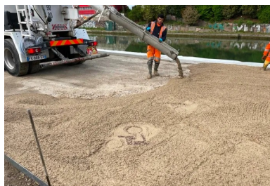
Le béton est acheminé à pied d'œuvre par camion-toupie et déversé sur la fondation en grave traitée au LHR. (©Sébastien Vinatier/Sols)
