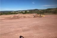
ement de terre. Le matériau est acheminé et mis en place en couches sseur variable en fonction de la zone, afin de conférer à la plate-forme les éristiques topographiques visées. (© Scierie-Gaiffe et Avinim
