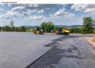
Mise en œuvre de la couche de surface en BBSG. (© Scierie-Gaiffe et Av
