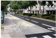
Photo 6 : Chaussée renforcée en béton à un arrêt de bus à Angers/Transbus.on
