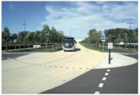
Photo 5 : Plate-forme en béton pour Bus à Haut Niveau de Service BHNS, Melun-Sénart (c) CIMbéton
