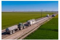
Photo 2 : chantier de retraitement des chaussées en place à froid aux liants hydraulgiues routiers (c) CIMbéton
