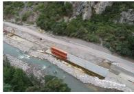
Saorge, RD 6204. Brèche n° 12 : réalisation d'un mur cantilever en béton coulé en
