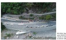
RD 6204. Réalisation d'une paroi AD/OC® et d'une paroi clouée en béton projeté pour la brèche 18b.
