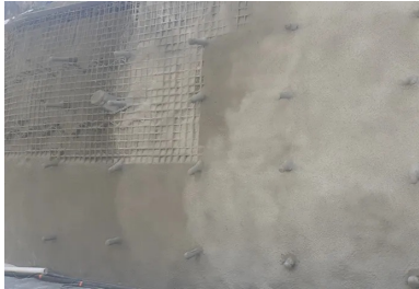
Paroi clouée, brèche n° 40.
