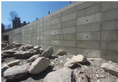
Mur poids en écaïlles préfabriquées pour la brèche n° 19.
