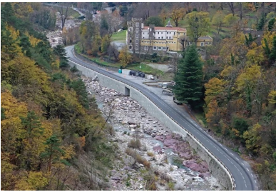
La route est désormais protégée et contenue par de nouveaux soutènements en béton : un mur poids et un ouvrage hydraulique préfabriqué.
