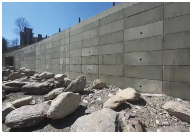
Mur poids en écaillies préfabriquées pour la brèche n° 19.
