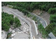
RD 91. Brèches n° 2 et 3 : réalisation d'un mur cantileve en béton coulé en place (8 m de haut) surmonté d'un deuxième mur en ModBloc® (mur poids en blocs béton préfabriqués).
