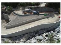
RD 91. Reconstruction des lacets du lac des Mesches avec des murs en remblais renforcés en RediRock® pour garantir une esthétique soignée.
