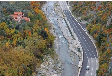
Saorge, RD 6204. Brèche n° 12 : réalisation d'un mur cantilever en béton coulé en place.
