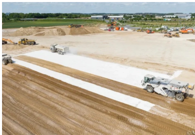
Atelier de traitement. Au fond un épandeur du liant en action et au premier plan deux pulvimixeurs mélangent le liant avec le sol sur une épaisseur bien définie. (© Colas)
