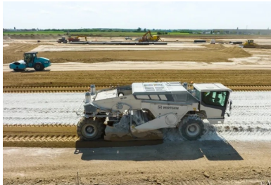
Le sol est malaxé avec le liant à l'aide d'un pulvimixeur moderne. Au fond, un compacteur en action. (© Colas)
