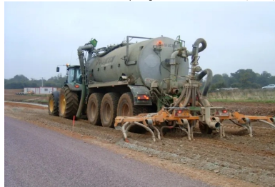
La teneur en eau du sol est ajustée à la teneur de l'optimum Proctor à l'aide d'une arroseuse-enfouisseuse. (©Colas)
