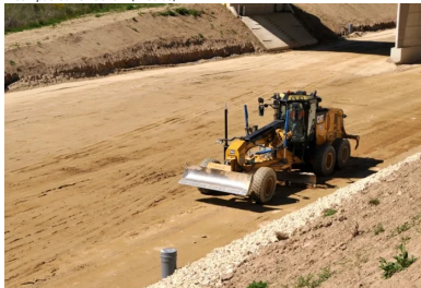
Réglage à la niveleuse pour obtenir un profil en long très régulier. (© Colas)
