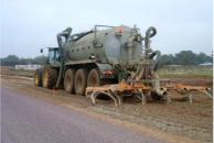
La teneur en eau du sol est ajustée à la teneur de l'optimum Proctor à l'ai d'une arroseuse-enfouisseuse. (©Colas)
